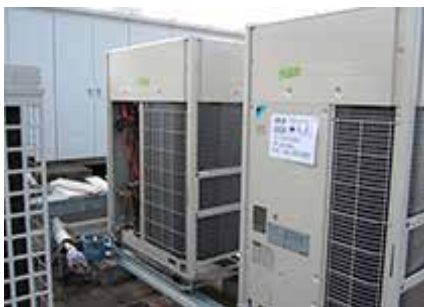
ビル用マルチエアコン更新工事
