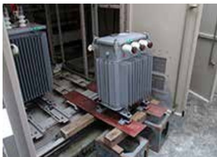
変電室改修工事(老人ホーム)
