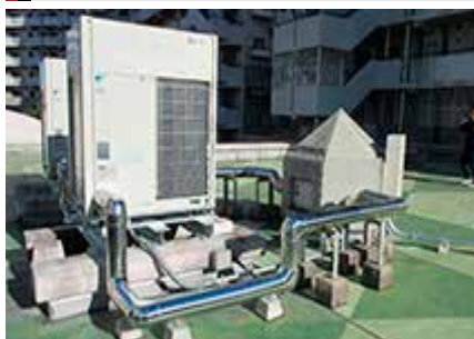
空調機更新工事(老人ホーム)
