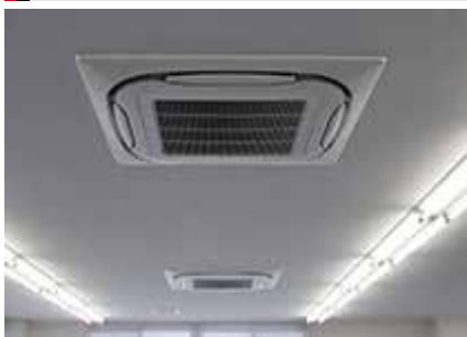
新築空調設備工事(老人ホーム)
