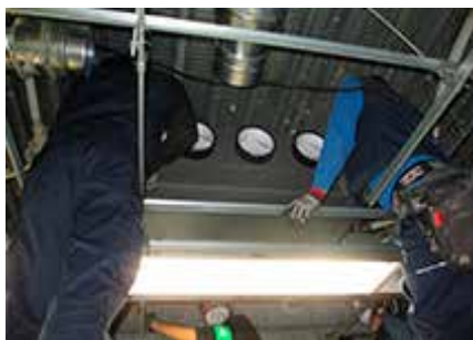
空調機更新工事(ビル)
