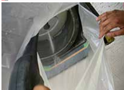
エアコン分解洗浄
