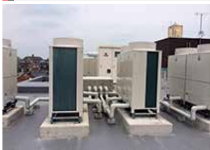
新築空調設備工事(老人ホーム)
