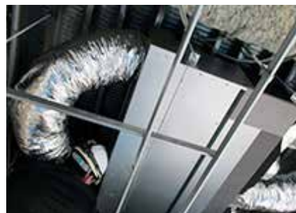
空調機更新工事(室内機)
