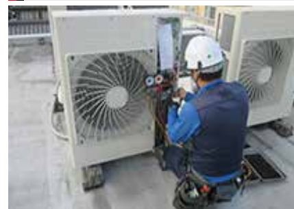
業務用空調機修理
