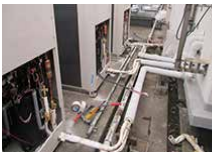
空調機更新工事(老人ホーム)
