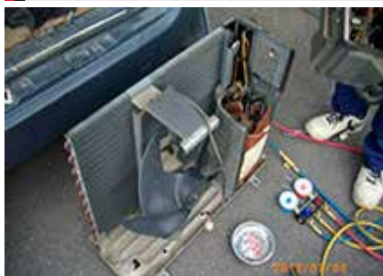
ルームエアコン修繕
