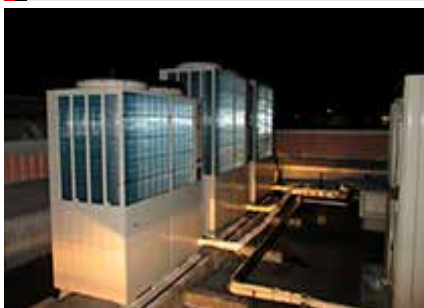
空調機更新工事(ドラッグストア)
