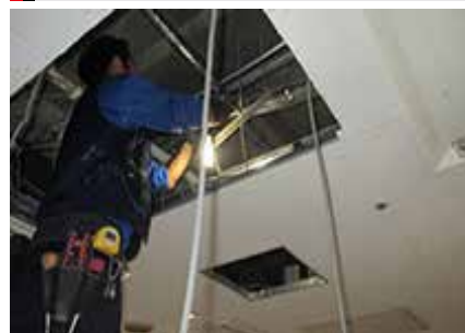
空調機更新工事(店舗)
