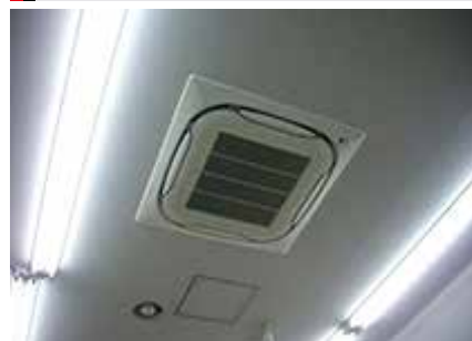
空調機更新工事(ドラッグストア)
