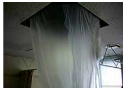
エアコン分解洗浄
